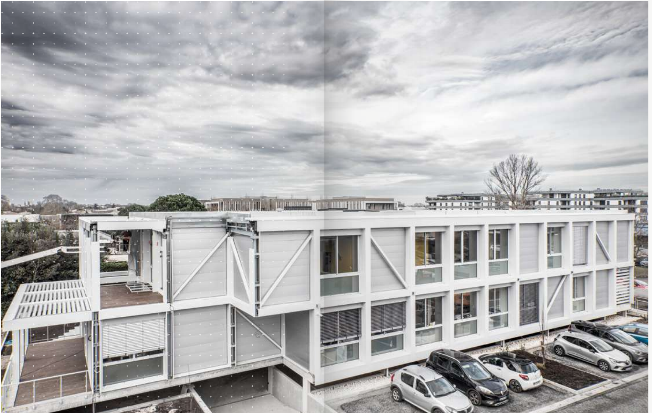
SIÈGE SOCIAL JDC (2024) > Bardage en cours de finition - Photographie Maxime Gautier®
