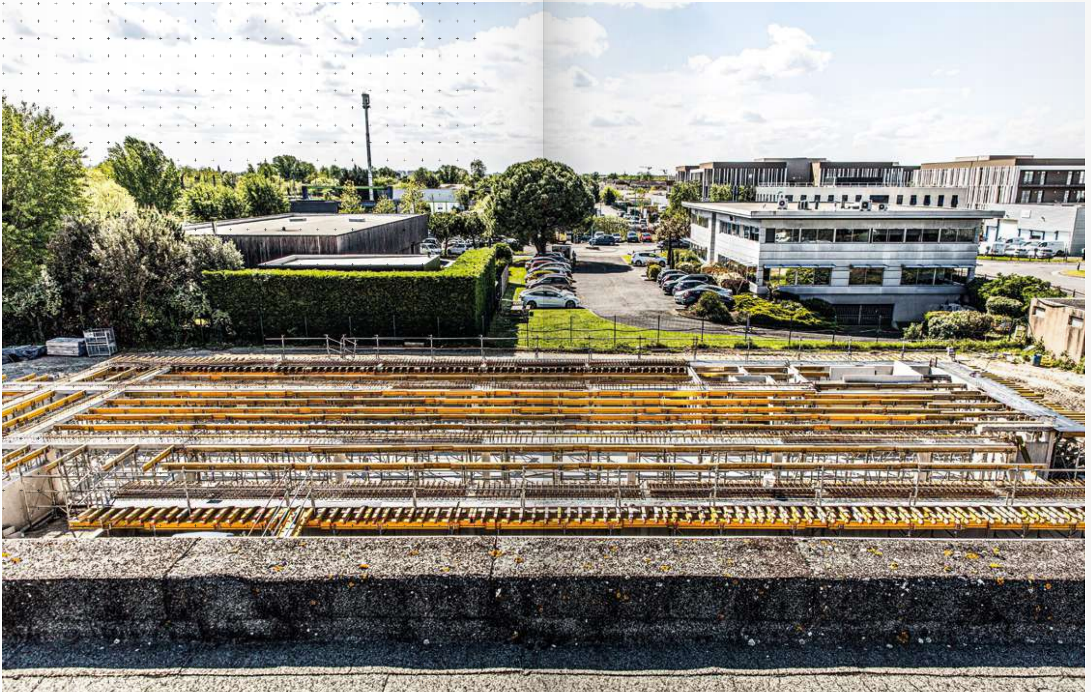
SIÈGE SOCIAL JDC (2024) > Fondations bâtiment - Photographie Maxime Gautier ©
