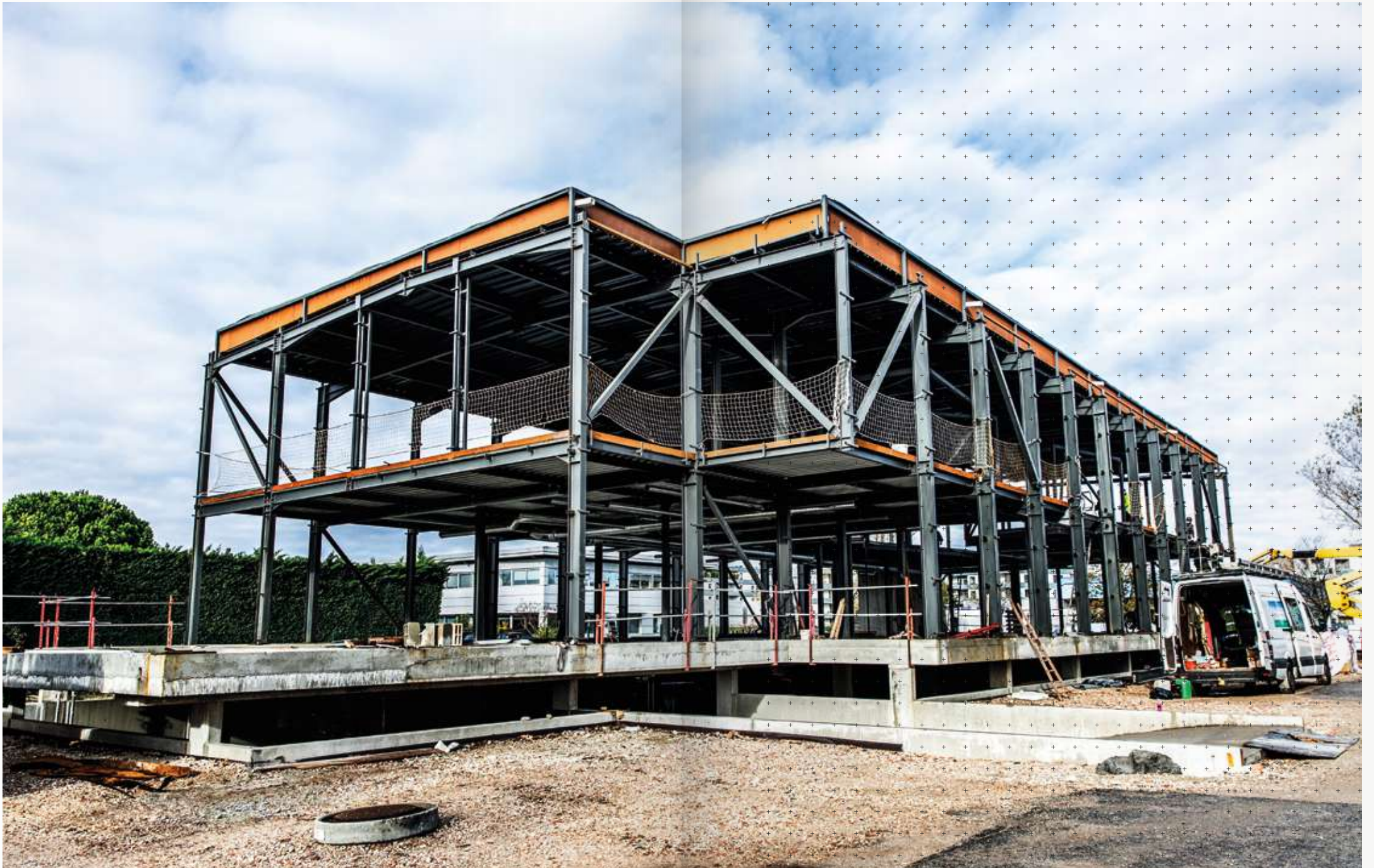
SIÈGE SOCIAL JDC (2024) > Structure métallique - Photographie Maxime Gautier ©
